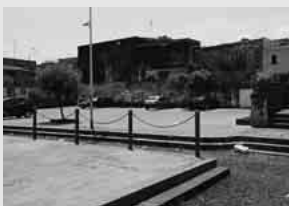
Uno scorcio di piazza De Andrè, nel quartiere Camposanto vecchio. In vista lavori di riqualificazione (Foto Di Guardo)
