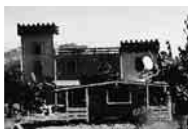
LA STRUTTURA CONTESTATA
