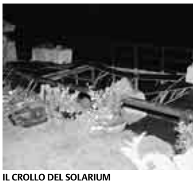
IL CROLLO DEL SOLARIUM
